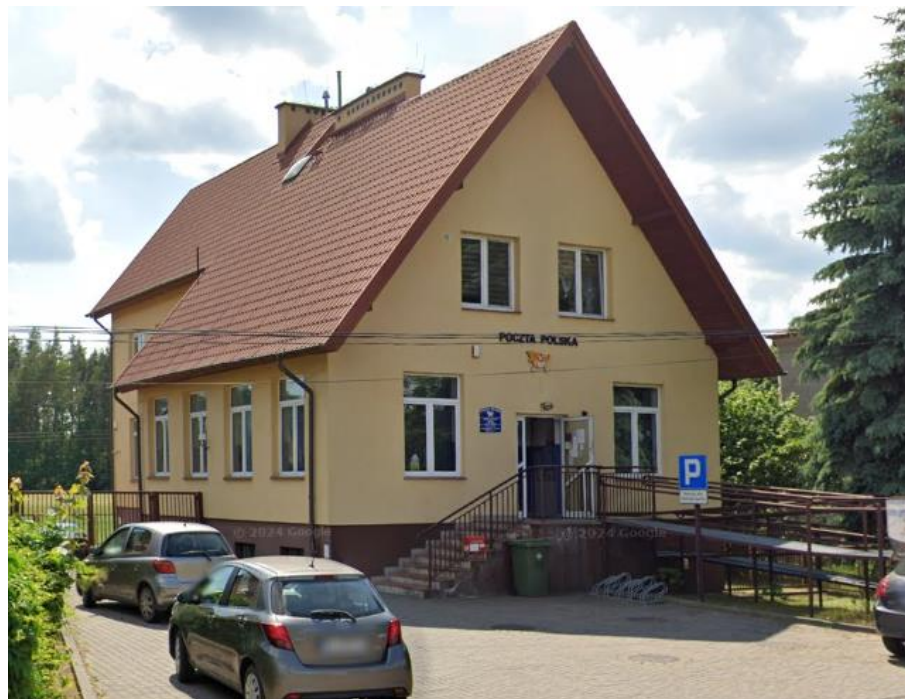
Budynek Poczty Polskiej S.A. w miejscowości Zbójna, Łomżyńska 21
